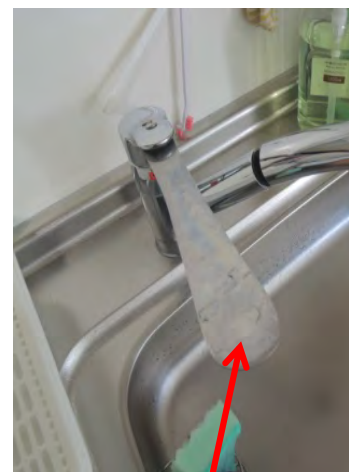
蛇口に延長レバーを取付け
