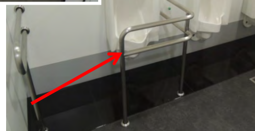
転倒防止バー設置
